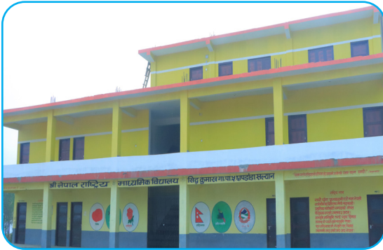
नव निर्मित ने.रा.मा.वि.को विद्यालय भवन
